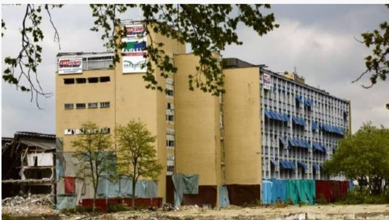
Nadat al het bruikbare materiaal was verwijderd liet Van Liempd in mei dit oude Philipsgebouw imploderen. De resten worden toegepast in de wegenbouw. Zie hier de operatie. (Rob Huibers)
